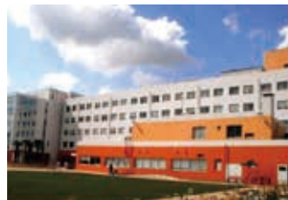
新上三川病院 栃木県河内郡上三川町上三川2360 TEL 0285-56-7111
