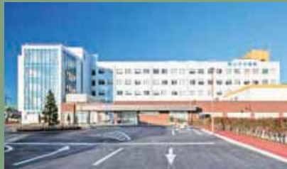
新上三川病院 栃木県河内郡上三川町上三川2360 TEL.0285-56-7111
