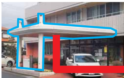
■ 正面玄関ポーチ
